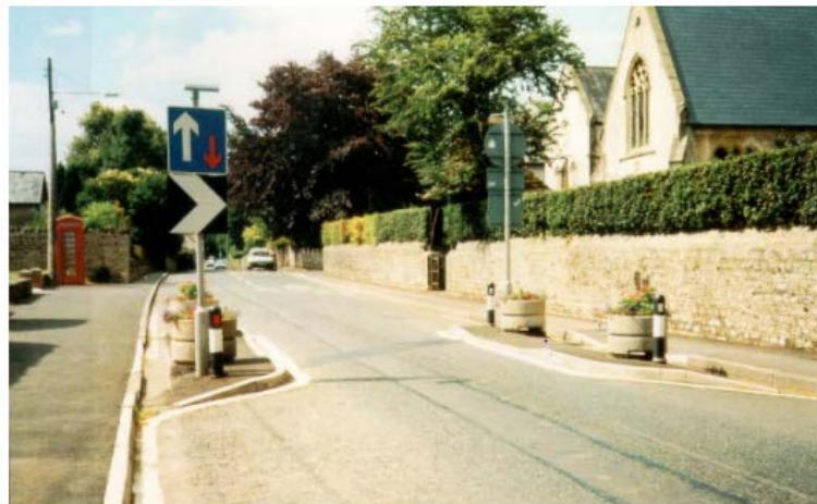
Figura 10: Redução da largura da via permitindo a passagem de um veículo. FONTE (BHTRANS, 1999)
