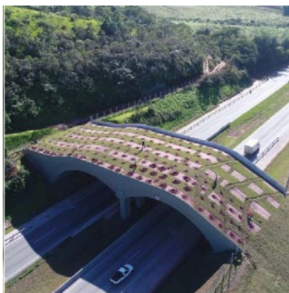
Figura 1: Viaduto vegetado inaugurado na BR-101, em Silva Jardim, no RJ. FONTE: RJ – 101, G1, 2020.
