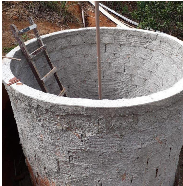
Figura 8 - Biodigestor em construção.
