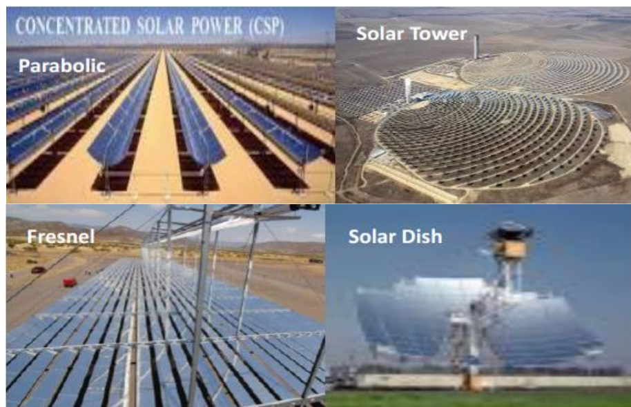
Figura 7: Tipos de concentradores solares Fonte: MME, 2014
