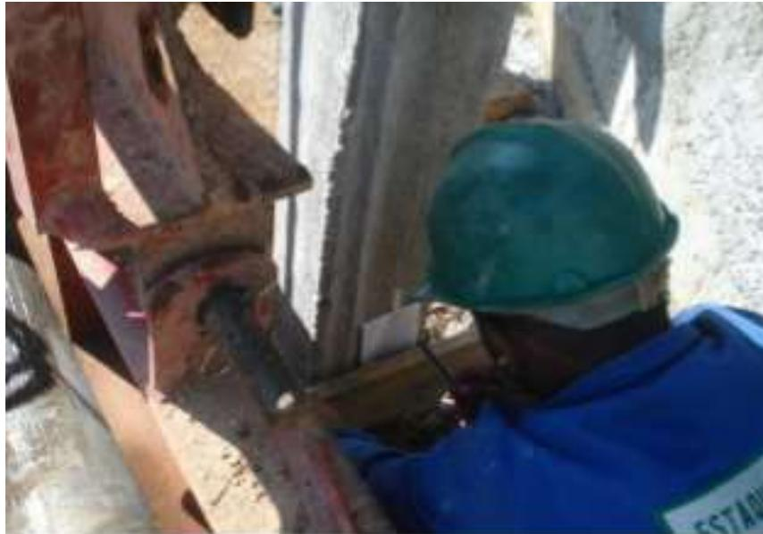
Figura 2.8 Verificação da nega – <http://Geocities.ws/fundacoesufsc20082/f6.JPG>, Marchezini (2013).
