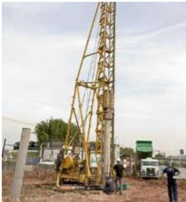
Figura 2.12: Bate estaca para altura crescente de queda.
