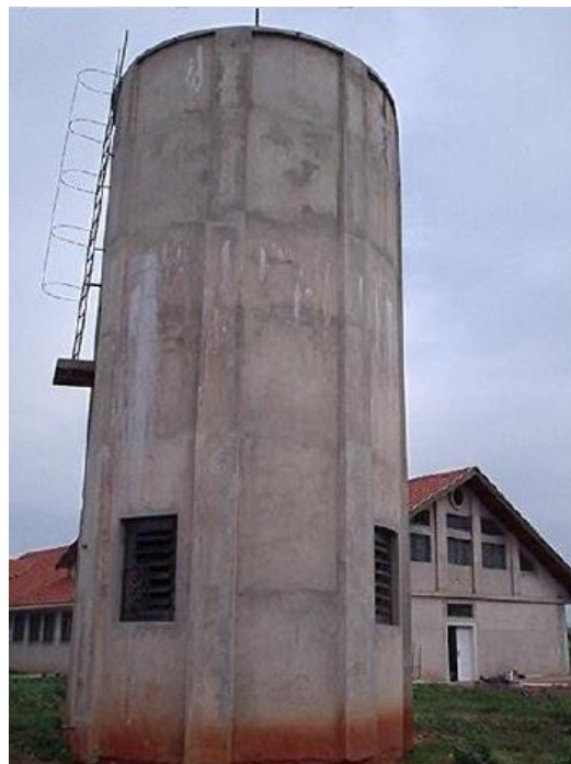
Figura 8: Reservatório apoiado de alvenaria
