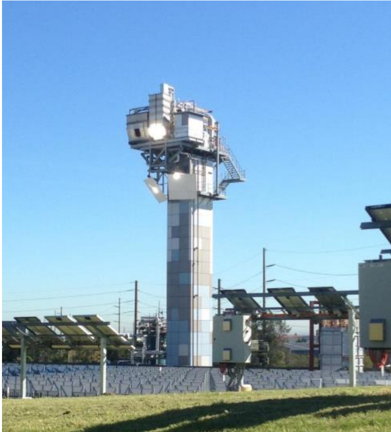
Figura 13: Torre solar modelada em um Ciclo Brayton da CSIRO Fonte: CSIRO solar air turbine Project final report, 2014
