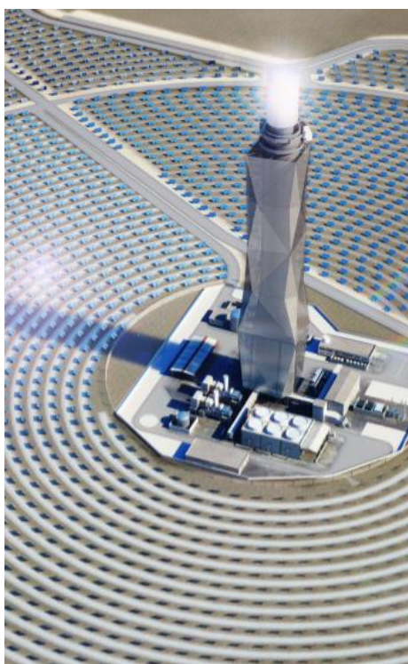
Figura 3:Protótipo da Torre Solar Ashalim Fonte: GE Renewable Energy, 2016
