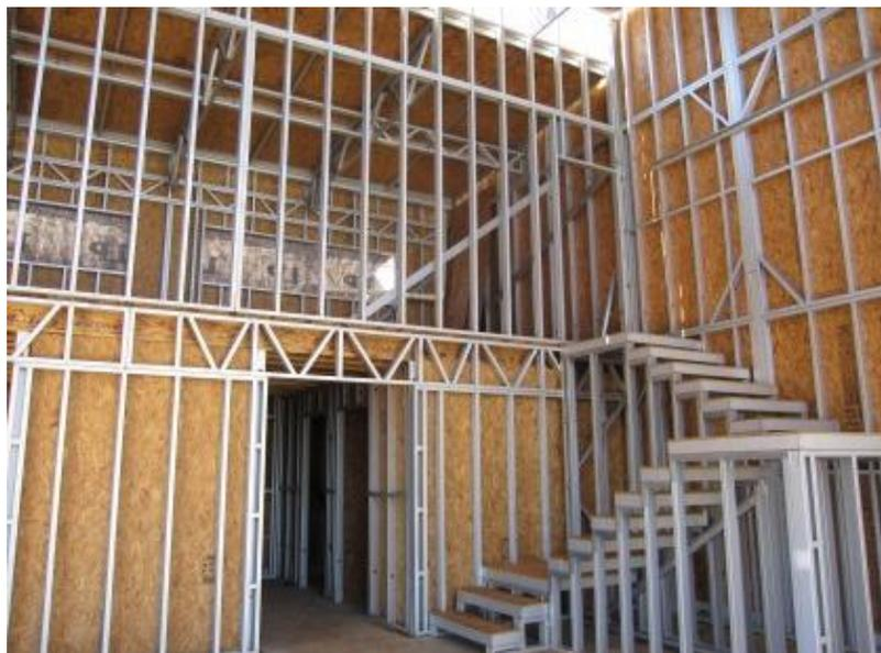
Figura 2.5 – Construção com vedação interna em placas OSB, (<http://www.lpbrasil.com.br/produtos/lp-osb-home-plus>).
