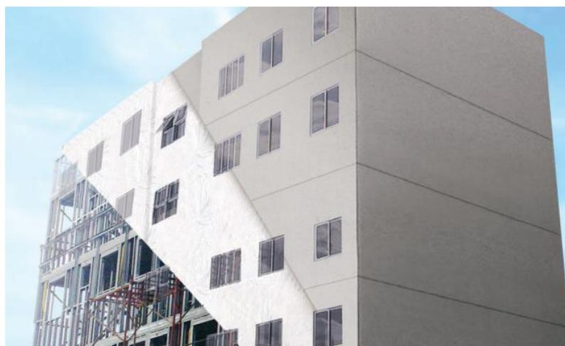
Figura 2.6 – Edifício em estrutura metálica e vedação externa em LSF e placas cimentícias, ([http://www.brasilit.com.br/sites/default/files/catalogos\\_folhetos/Cat%C3%A1logo-PlacaCiment%C3%ADcia-Brasilit.pdf](http://www.brasilit.com.br/sites/default/files/catalogos_folhetos/Cat%C3%A1logo-PlacaCiment%C3%ADcia-Brasilit.pdf)).
