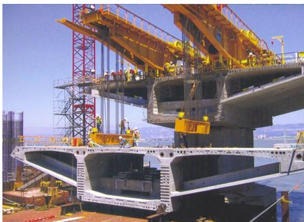
Figura 9 – Ponte em viga com Seção celular
