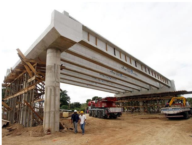
Figura 8 - Viaduto da Dom Orlando Chaves em viga com seção T
