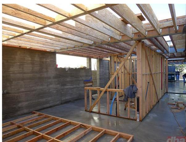
Figura 2.10 - Execução de estrutura de madeira.
