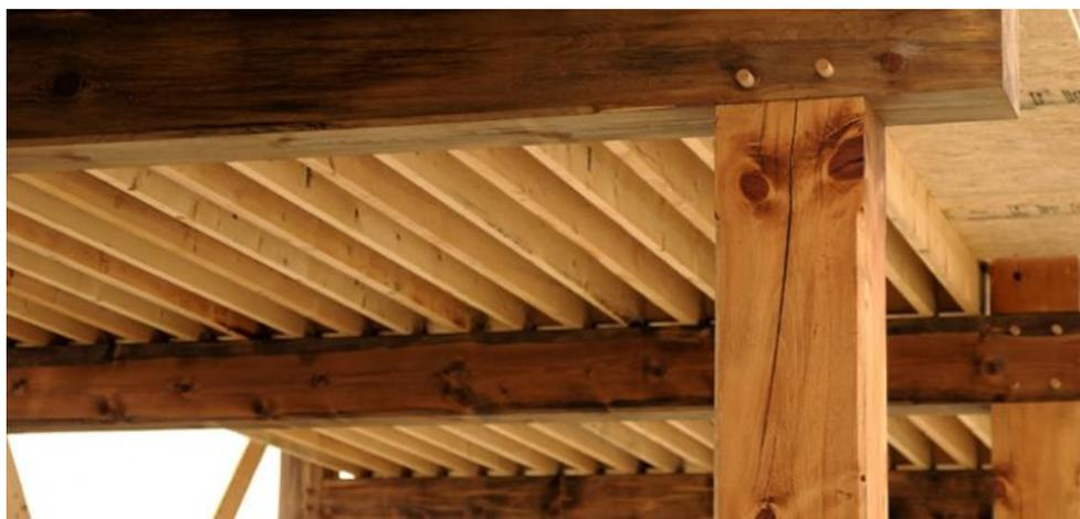
Figura 2.7 – Vigas de piso apoiadas sobre vigas principais.
