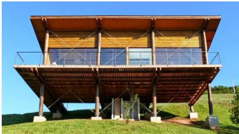
Figura 2.14 – Cabos de contraventamento.
