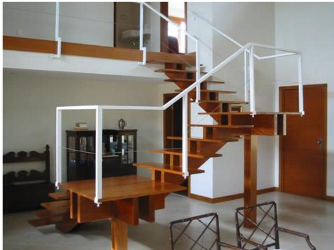
Figura 2.20 – Patamares da escada apoiados sobre pilares de madeira.
