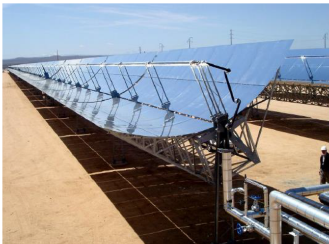
Figura 5 – Planta com tecnologia de calha parabólica
