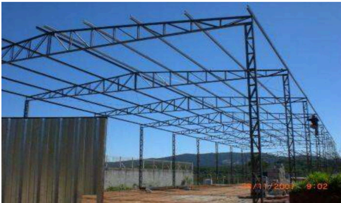
Figura 1.1 – Edifício Industrial Formado por Pórticos Treliçados, (MADEIRA, 2009).
