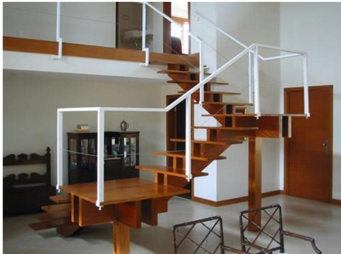
Figura 2.15 – Patamares da escada apoiados sobre pilares de madeira.
