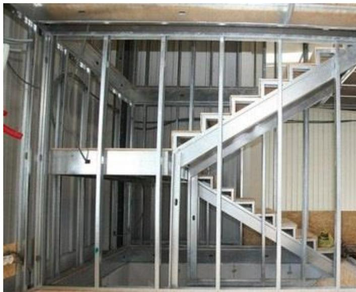
Figura 2.17 – Vergas inclinadas apoiadas nos montantes verticais.
