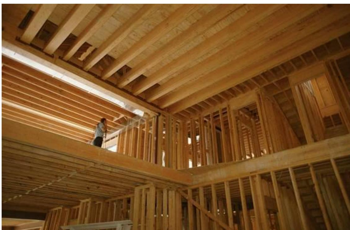
Figura 2.10 - Estrutura em *wood frame*.
