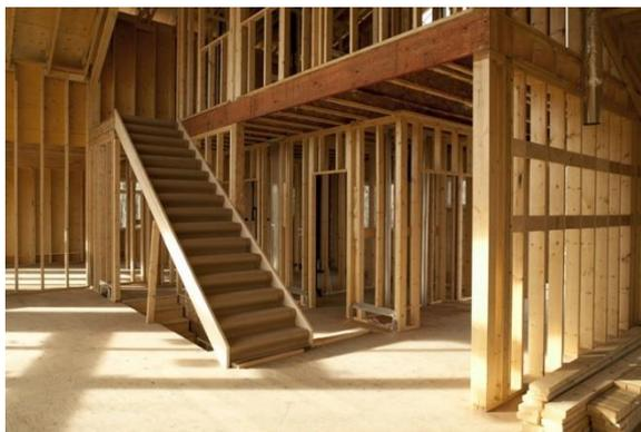
Figura 2.9 – Detalhes dos painéis estruturais e do sistema de lajes.
