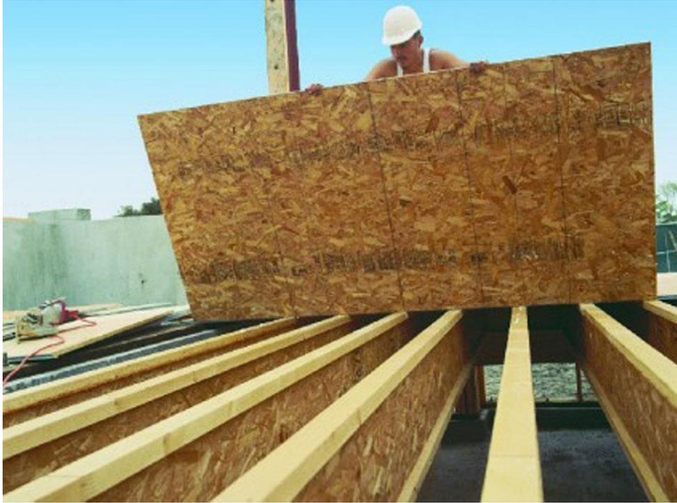
Figura 2.7 – Placa OSB apoiada sobre as vigas de piso.
