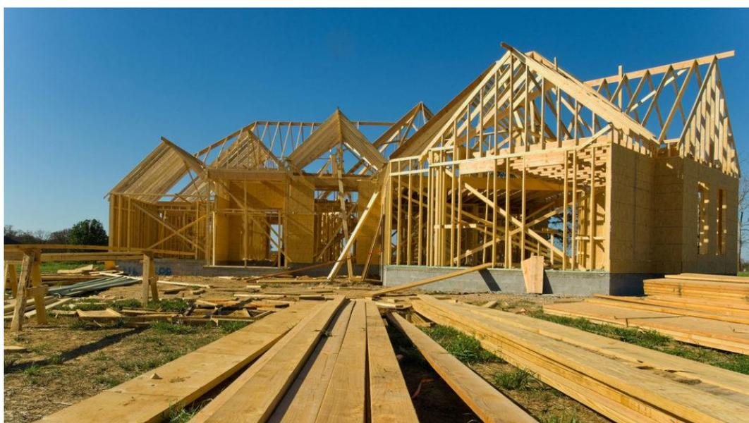
Figura 2.6 – Obra executada com sistema *wood frame*.
