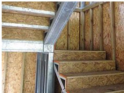
Figura 2.16 – Patamares da escada apoiados sobre painéis estruturais, neste caso a estrutura é em *steel framing*.
