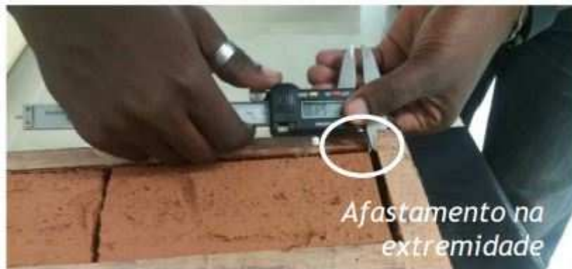
Figura 42: Medição das trincas e afastamentos.
