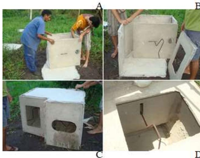
Figura 17: (A) Início da montagem das placas; (B) montagem das placas com colocação da manivela para aeração; (C) *Bason* com placas de plastocimento encaixadas; (D) montagem da câmara de compostagem.
