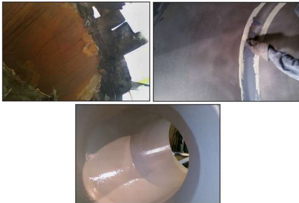
Figura 2: etapas da aplicação dos adesivos e resultado final. Fonte: https://arcindustrialcoatings.chesterton.com/Products/Pages/ARC858.aspx (acessado em 22/04/2019).
