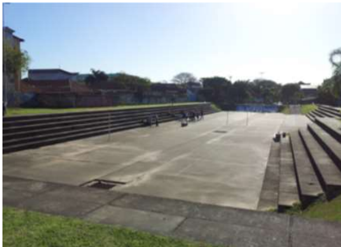
Figura 5: Reservatório de retenção a céu aberto. Fonte: ABCP (2013).
