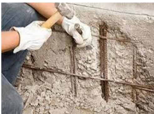
Figura 50: Procedimento de escarificação.
