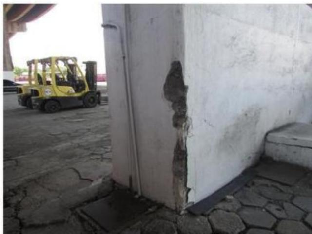
Figura 14: Estrutura disgregada devido ao choque mecânico de um veículo.
