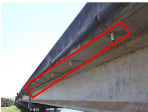
Figura 29: Balanço laterais com presença de buzinetes.
