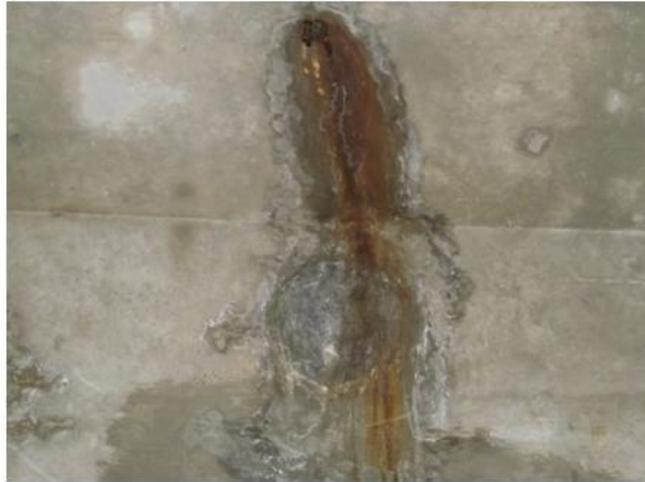
Figura 15: Manchas por infiltração por falta de buzinote.
