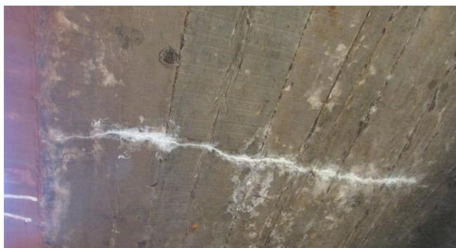
Figura 13: Eflorescência no tabuleiro de uma ponte.
