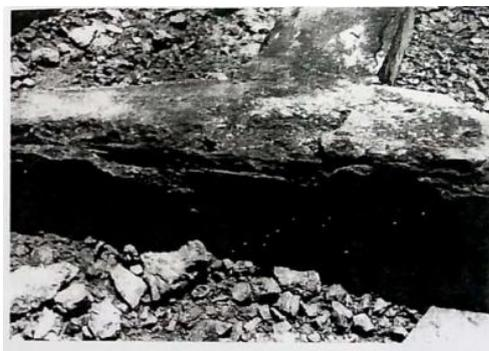
Figura 11: Crosta expansiva no entorno da armadura.
