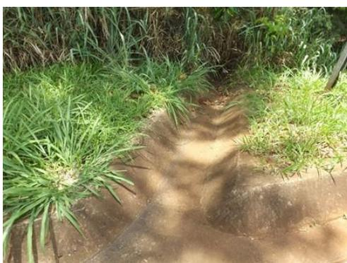
Figura 30: Drenagem da pista-canaleta tipo trapezoidal.
