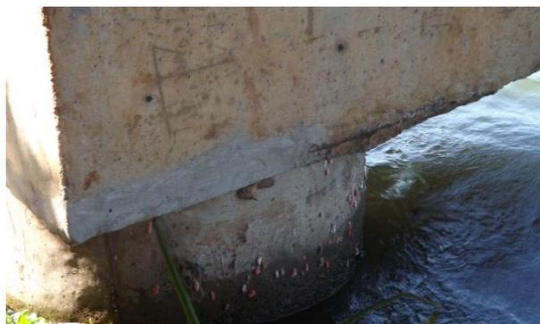
Figura 38: (8) Concreto desagregado no bloco de fundação.
