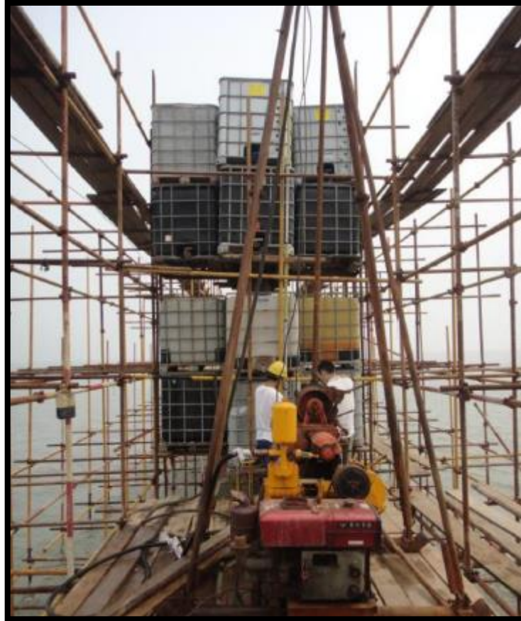
Figura 36 - Plataforma de madeira usada como base para passagem e instalação de equipamentos. Fonte: Kan et al. (2018).
