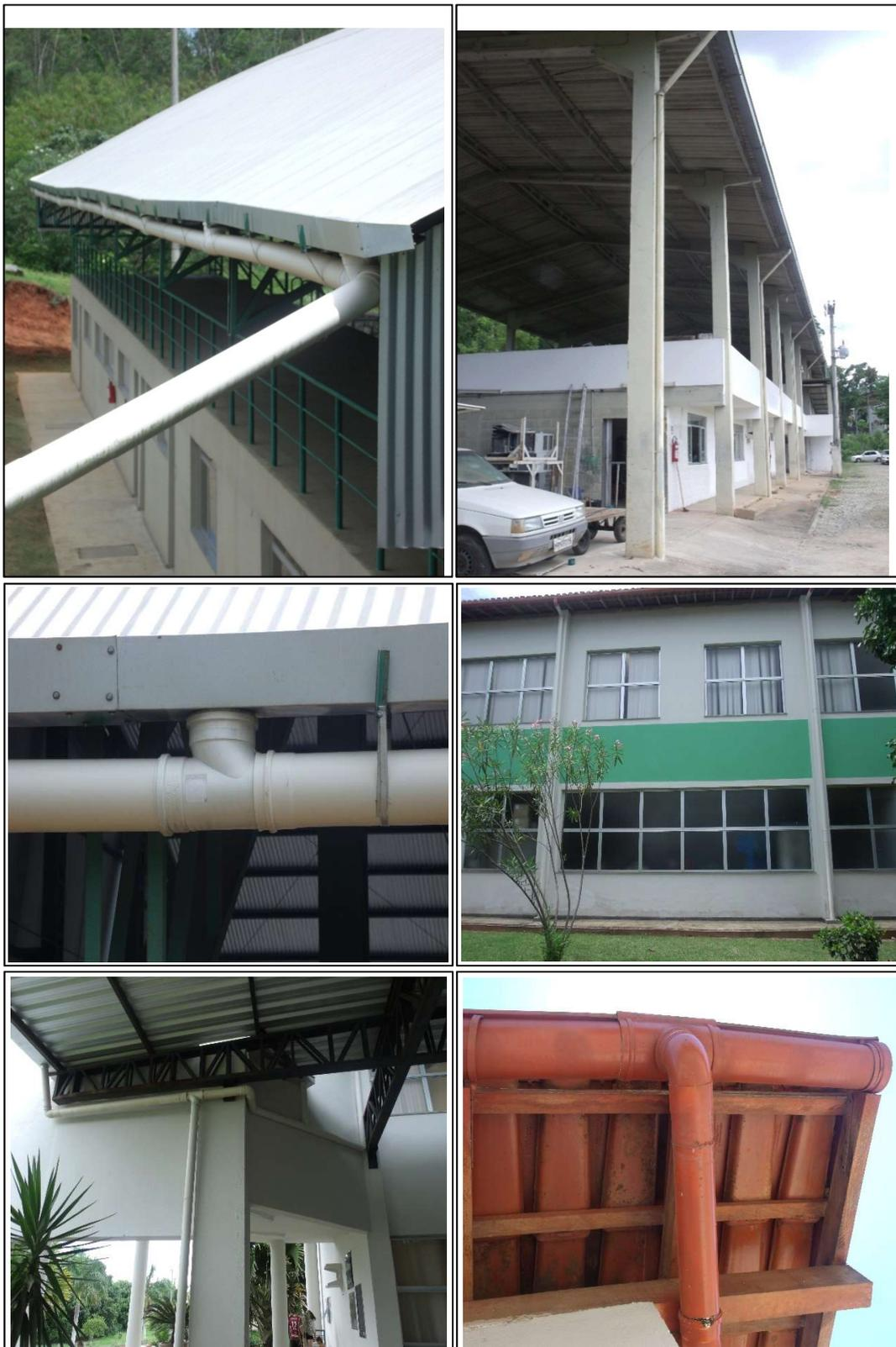
Figura 47: Calhas e Condutores Verticais instalados no IFES.
