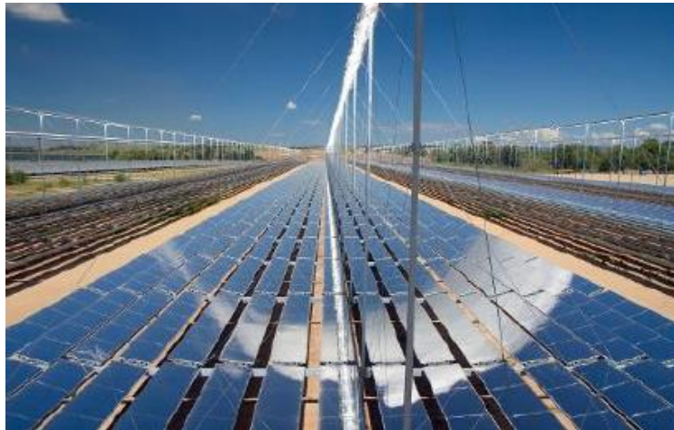
Figura 9 - Refletor Linear Fresnel.
