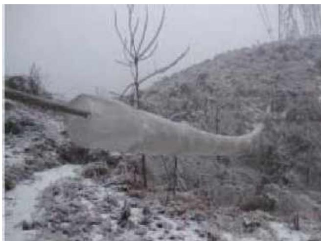
Figura 2.24 – Gelo Acumulado em uma Seção de Linha de Transmissão (Chen et al, 2015)
